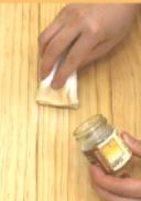
乾いたキレイなウエス(布)に、木部用塗料を染み込ませ、研磨した木部の表面に刷り込むように薄く拭き伸ばしていきます。
